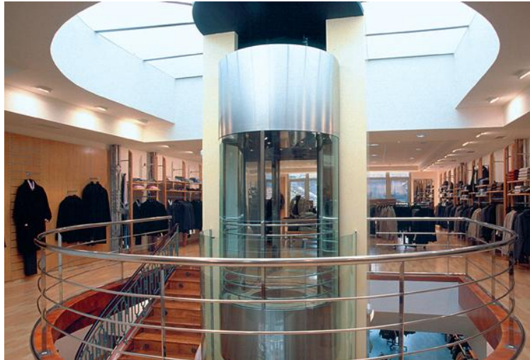
ILUSTRACIÓN 4: ASCENSORES FABRICADOS POR EMPRESAS DEL SECTOR METALMECÁNICO EN GALICIA
